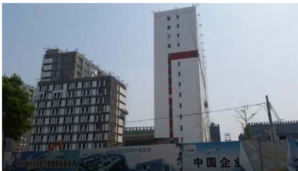
中国航信高科技产业园区
