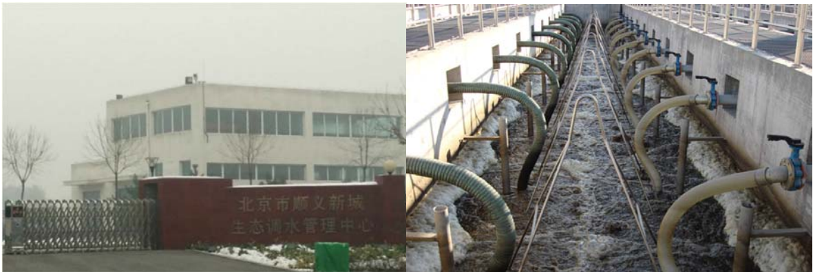
图 6-3 顺义新城生态调水管理中心现状照片
